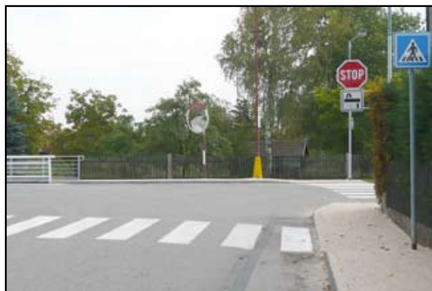
V obci Výrava byla ukončena obnova chodníků IV. a V. etapy, bezbariérového osvětleného přechodu s lávkou pro chodce přes Výravský potok.
